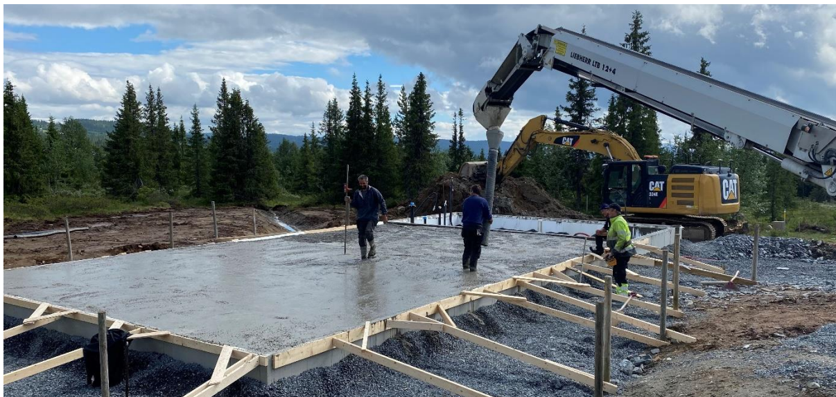
Støping av dekke til nytt uthus, 8 juli 2021 (foto: Gausdal fjellstyre)
